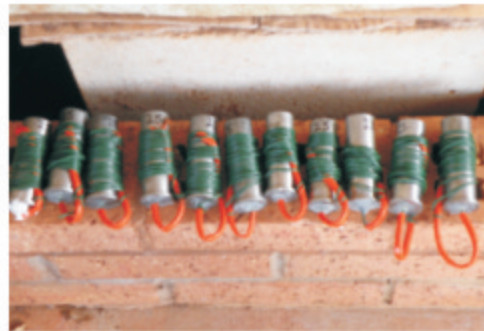
装填完火药和引线的炸药管
